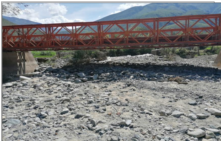
Fotografía N°02: Vista actual de colmatado en Quebrada Manta (aguas abajo).
